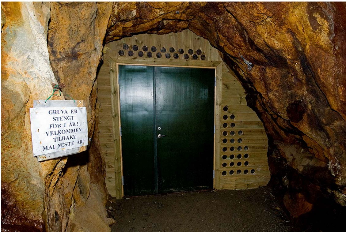
Figur 20. Perforert lettvegg i øvre inngang til hovedgruven. Foto: Jeroen van der Kooij.
