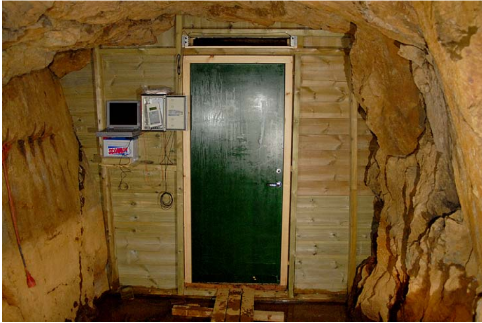
Figur 17. Lettvegg installert i nedre inngang til hovedgruven. Påmontert overvåkingsutstyr og innflygningsprekk over døren er synlig. Foto: Jeroen van der Kooij.
