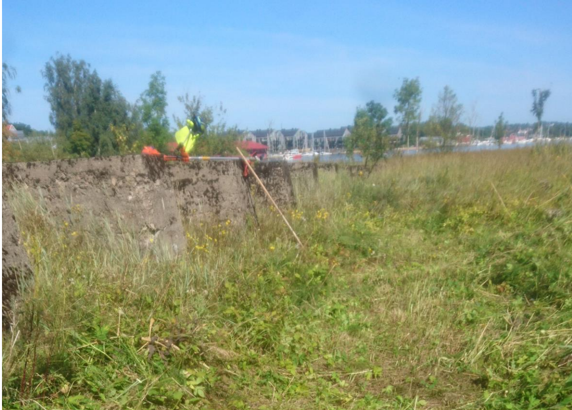
Figur 7. Takrøret ble fjernet i ei stripe på 3-4 m fra betongfundamentene. Slått materialet ble raket opp og deponert inne i takrørskogen. Foto: Ola Wergeland Krog.
