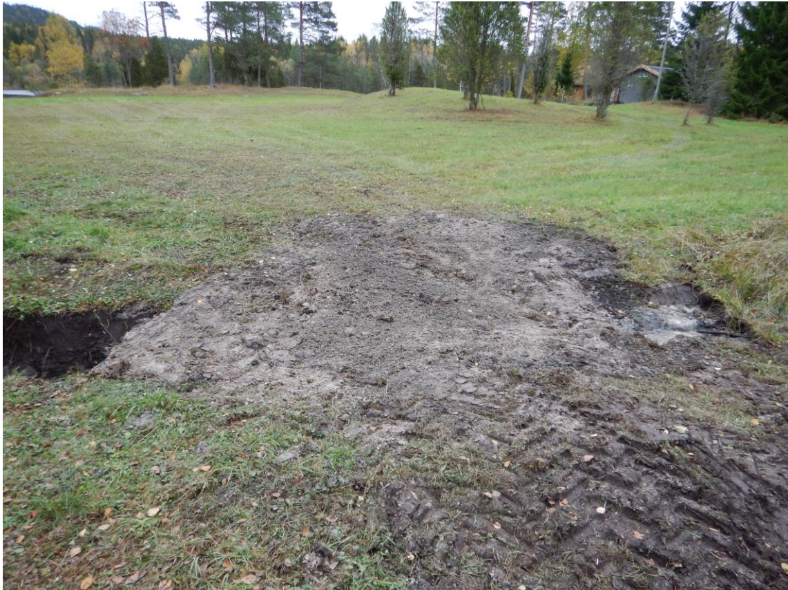
Fig. 5. For å kunne krysse over grøfta ble det lagt ned et 150 mm plastrør som ble overfylt med grus og et topplag med stedege masser. Foto: Ola Wergeland Krog.
