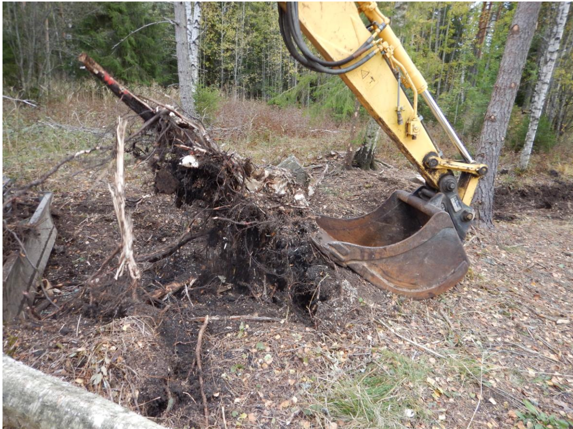
Fig. 4. Røtter og stubber i grøfta gjorde det nødvendig å velge vanlig graveskuff framfor planeringsskjær. Foto: Ola Wergeland Krog.
