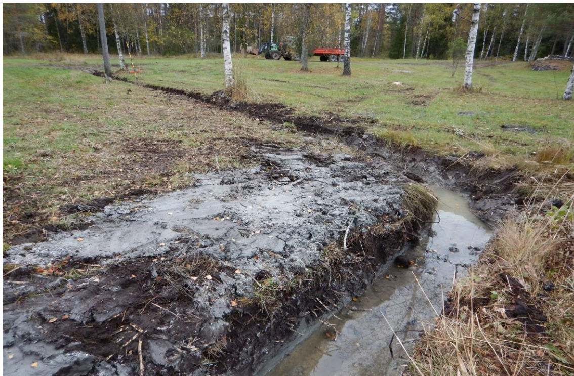
Fig. 11. Siste del av grøfta fra svingen og opp til krysningspunktet øverst til venstre i bildet. Foto: Ola Wergeland Krog.
