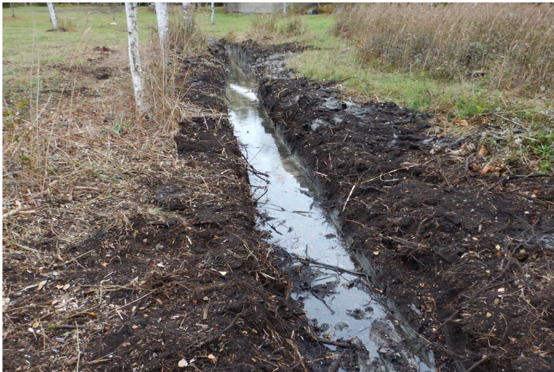
Fig. 10. Grøfta mellom utløpsgrøfta i figur 9 og vinkelen der den svinger sørover. Grøfta ble her gjort ekstra dyp for å kutte utløperne fra takrøskogen nord for grøfta (til høyre i bildet). Foto: Ola Wergeland Krog.
