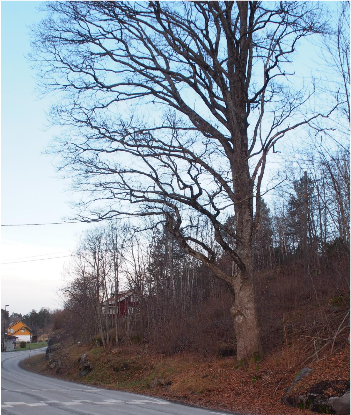
Figur 9. Den levende eika står i ei hylle i bergskråningen og har trolig ikke pålerot, men røtter utover mot sidene. Noen av disse røttene strekker seg utover den sprenkte kanten av hylla og gror nedover i grøfta og inn under veilegemet. Foto: forf.
