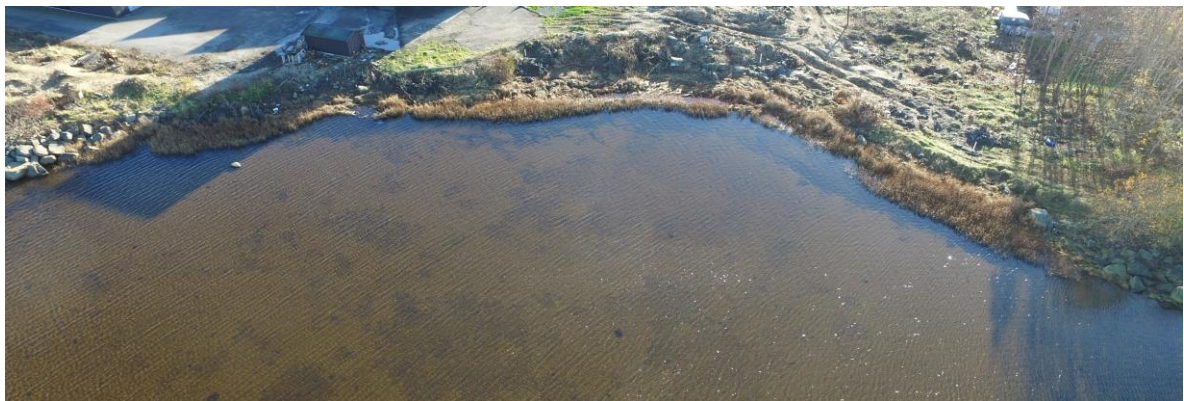
Figur 7. Bilde av strandkanten som er planlagt stabilisert. Bildet er tatt nordfra. Som det går fram av bildet består strandkanten av fyllmasser av varierende type fra grov stein til finere masser bevoskt med vannplanter. Foto: forf.
