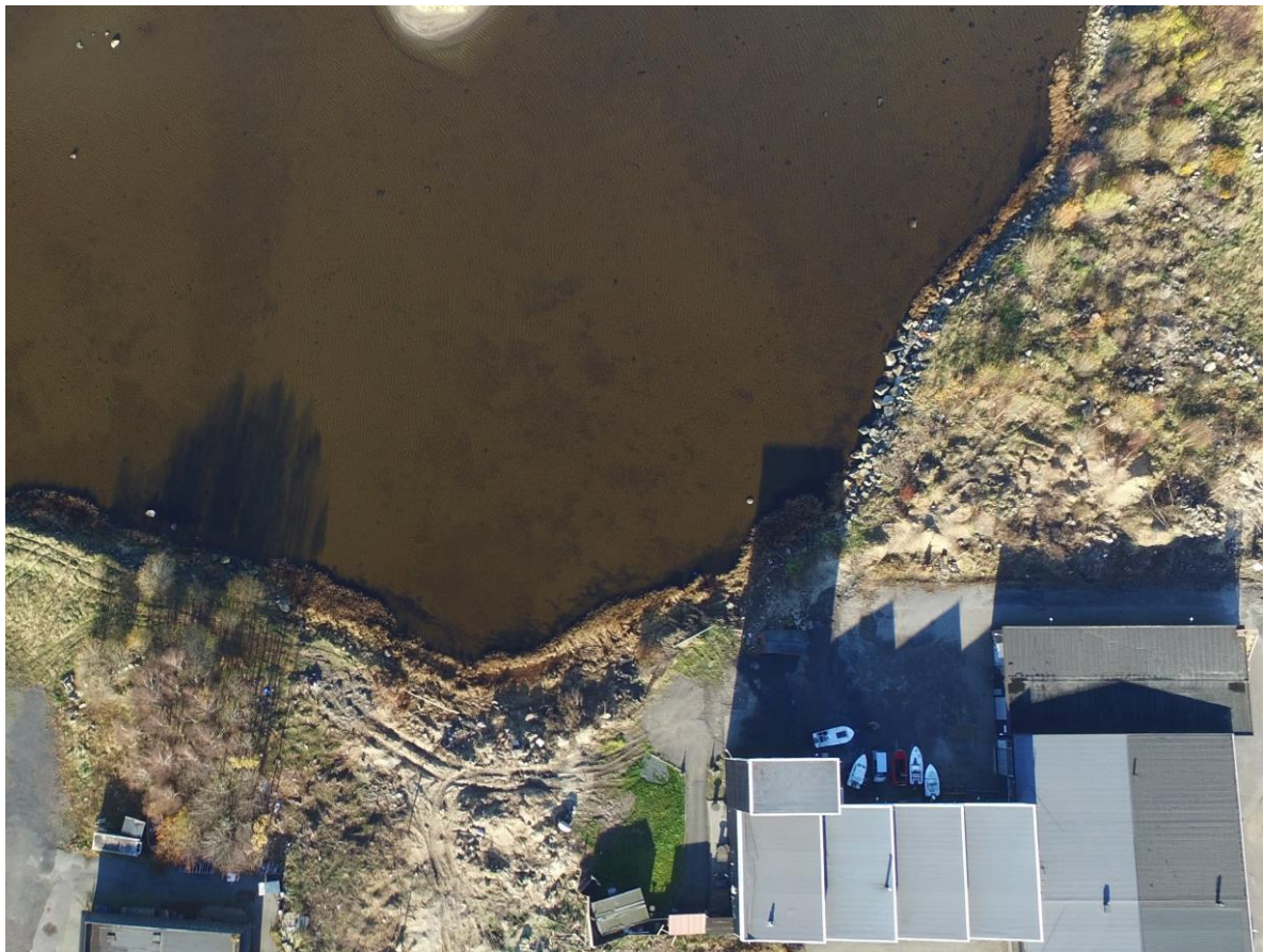
Figur 6. Dronebilde fra 2017 av strandkanten som planlegges stabilisert og hvor det planlagt grønstruktur. Foto: forf.
