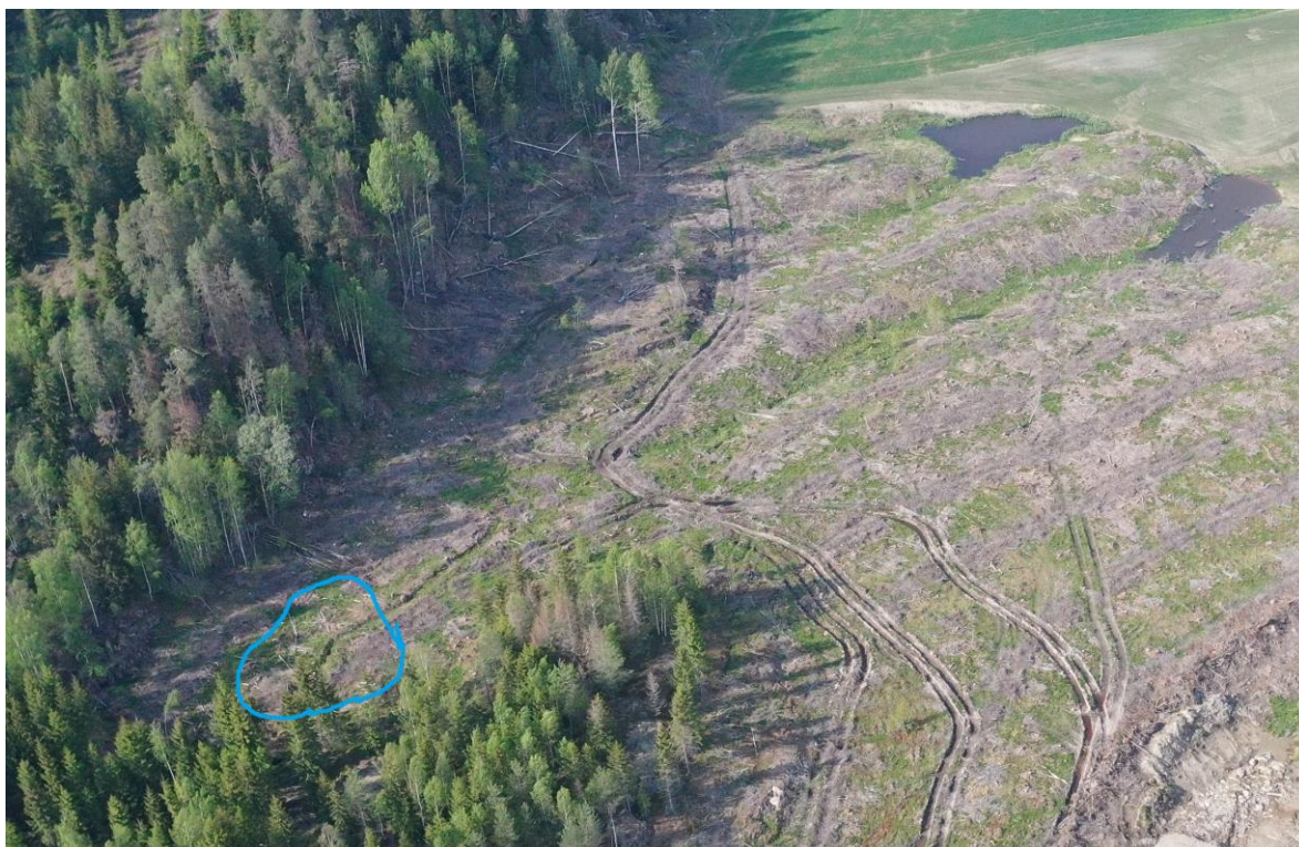
Figur 5. For å kompensere for de tre midlertidige dammene som vil forsvinne, kan tiltakshaver vurdere å anlegge en ny dam. Foreslått plassering er angitt på figuren med blå strek. Foto: forf.
